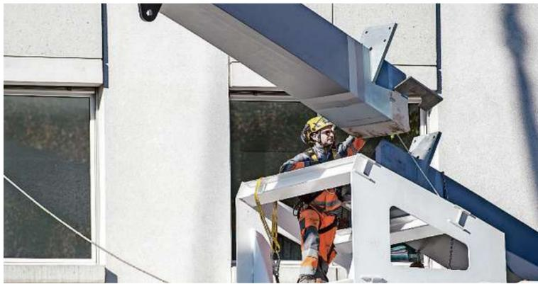
Abgehoben: Der mittlere Bogen der Brücke wird mit dem Kran in Position gebracht. Der Kranführer muss dabei bis auf drei Millimeter genau arbeiten.
